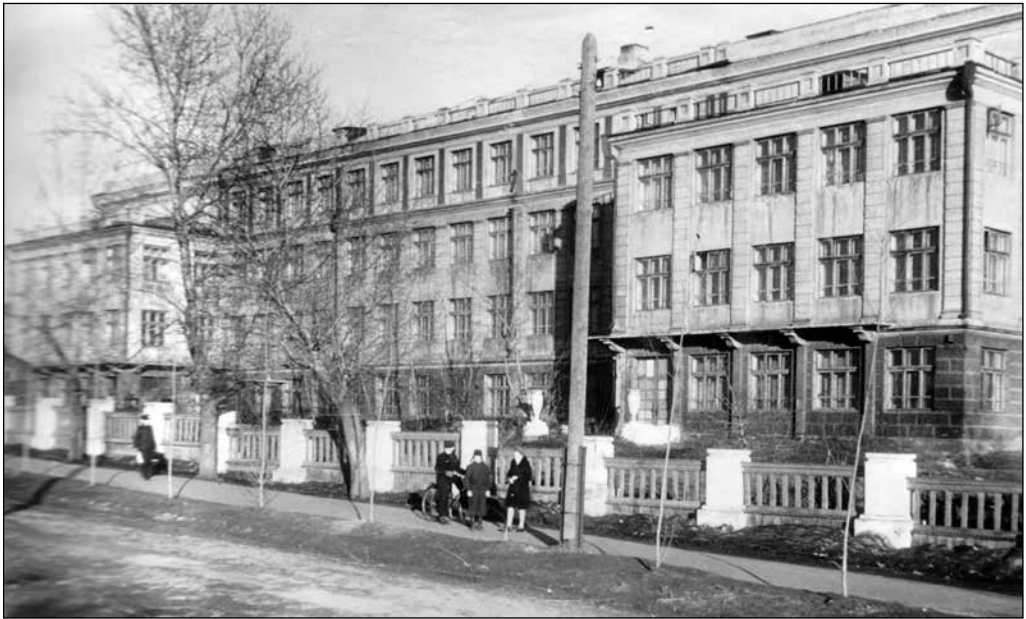
Общий вид здания на Комсомольском проспекте, 20, где в конце 1930-х годов располагался педагогический институт
