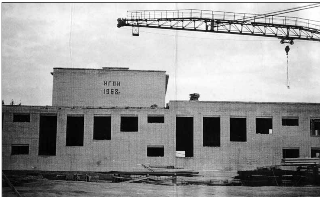
Строительство главного корпуса НГПИ в 1960-е годы
